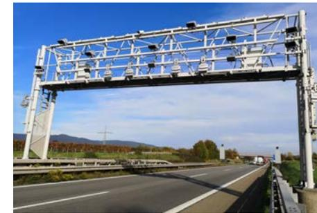
Die Kontrollbrücken und -säulen sind stationäre Einrichtungen, die im fließenden Verkehr beim Vorbei- bzw. Durchfahren eines Fahrzeuges kontrollieren, ob dieses mautpflichtig ist und die mautrelevanten Fahrzeugdaten korrekt deklariert wurden. Beim Passieren eines Fahrzeuges werden ein Übersichts-, ein Seitenansichts- und ein Kennzeichenbild erstellt.
